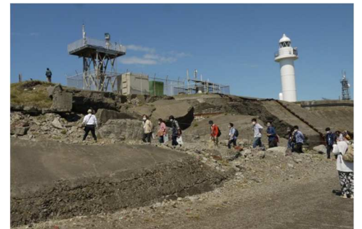
第二海堡の灯台と監視カメラ
